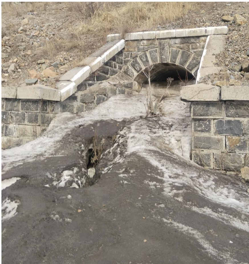
Рисунок 3 – Проход водотока в водопропускном сооружении железной дороги.
