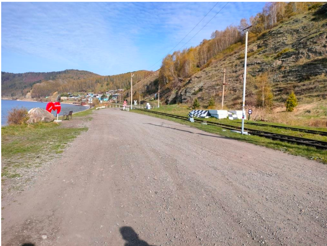
Рисунок Е.3 – Характерная ситуация по трассе проектируемой КВЛ 10 кВ на участке п. Байкал
