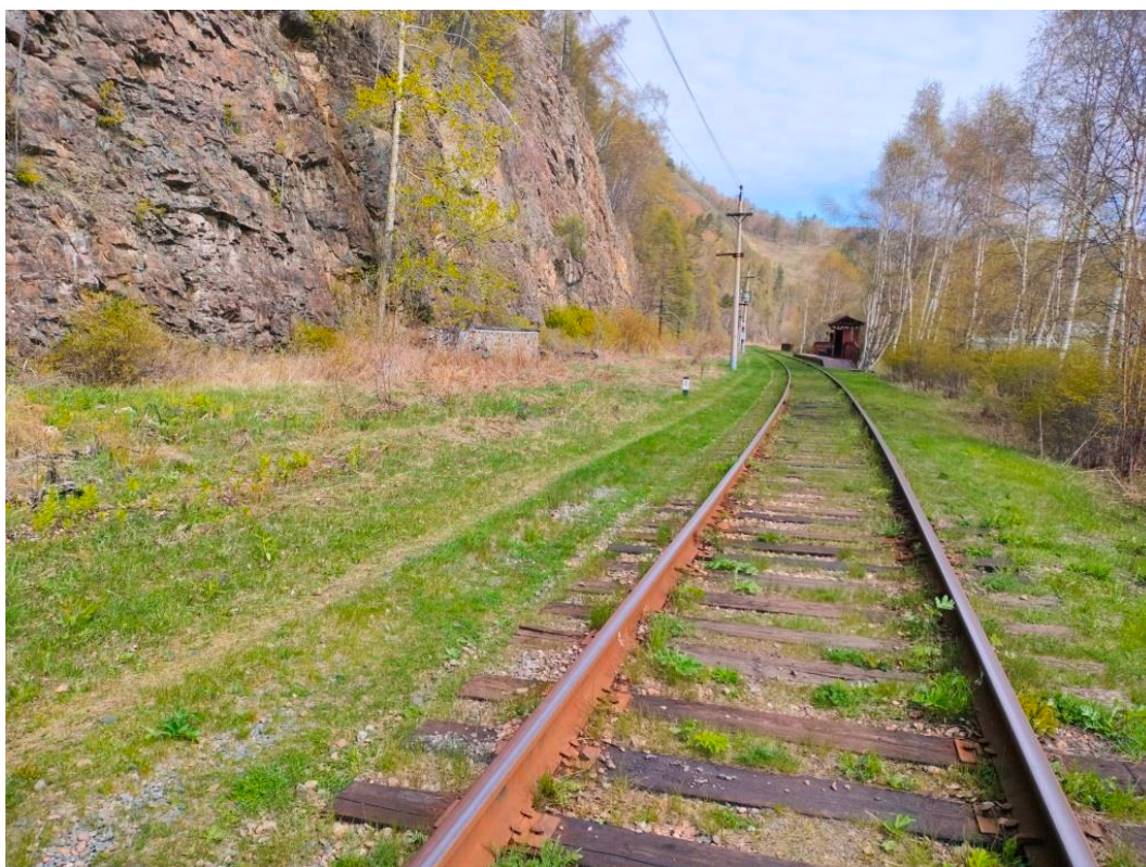
Рисунок Е.27 – Характерная ситуация на участке КВЛ 10 кВ в районе ОП 79 км
