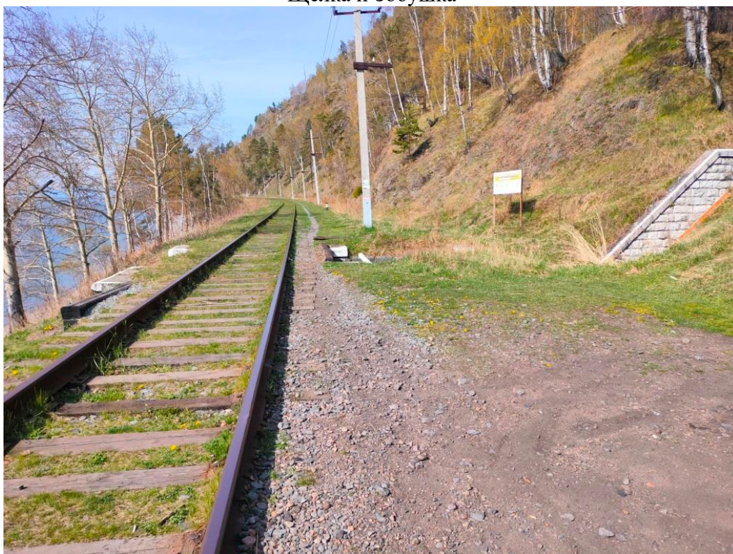
Рисунок Е.12 – Характерная ситуация по трассе проектируемой КВЛ 10 кВ на участке между р. Щелка и Зобушка
