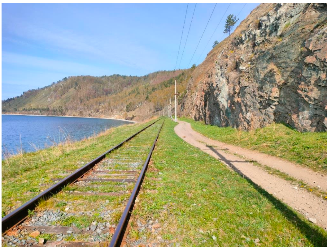
Рисунок Е.11 – Характерная ситуация по трассе проектируемой КВЛ 10 кВ на участке между р. Щелка и Зобушка
