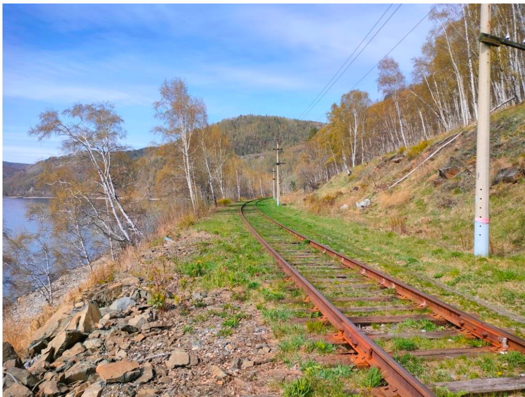
Рисунок Е.19 – Характерная ситуация на участке КВЛ 10 кВ после противооползневой галереи №1
