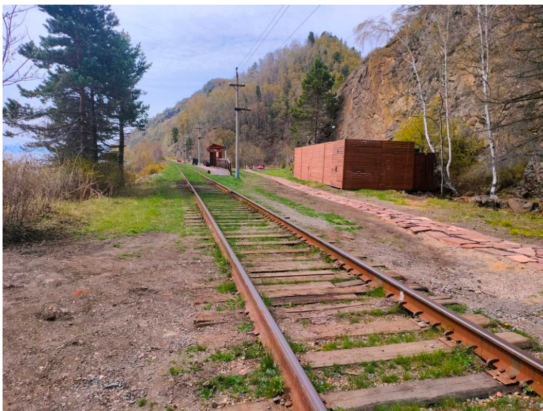
Рисунок Е.29 – Характерная ситуация на участке КВЛ 10 кВ в районе ОП 80 км
