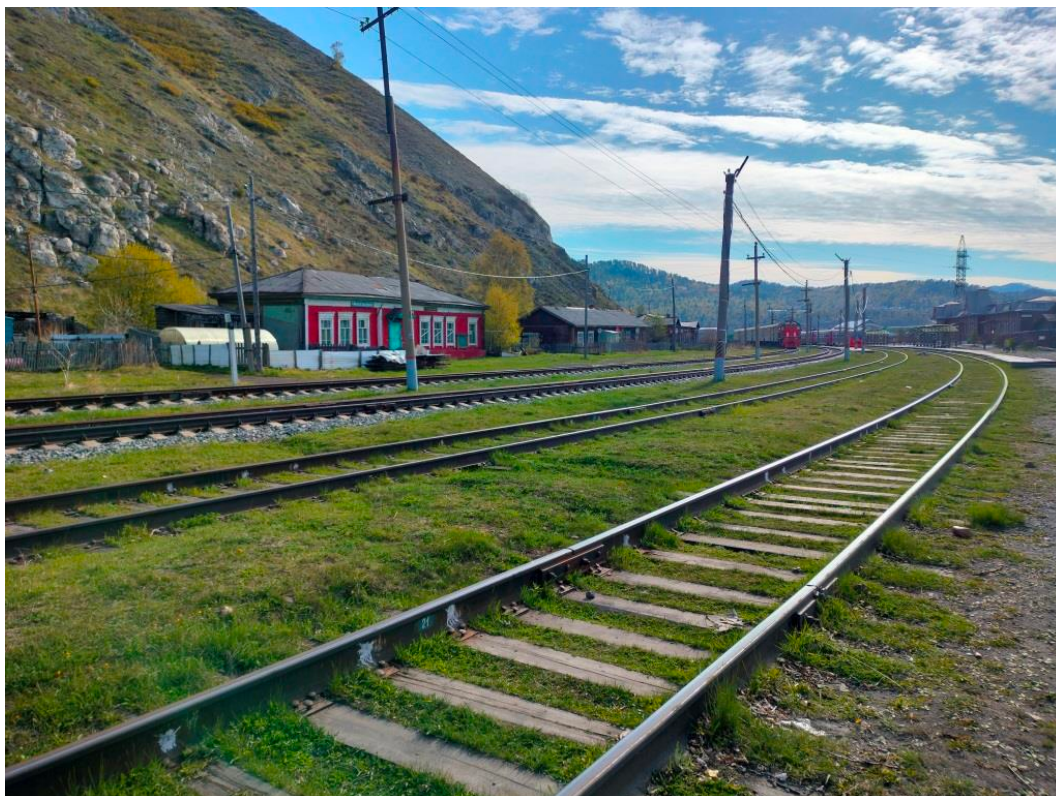
Рисунок Е.35 – Характерная ситуация в начале трассы КВЛ 10 кВ в п. Байкал
