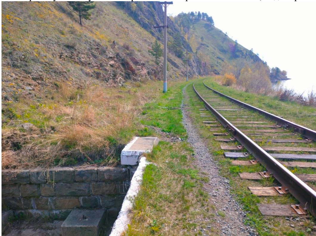
Рисунок Е.16 – Характерная ситуация на участке пересечения с трассой КВЛ 10 кВ с р. Марьяная
