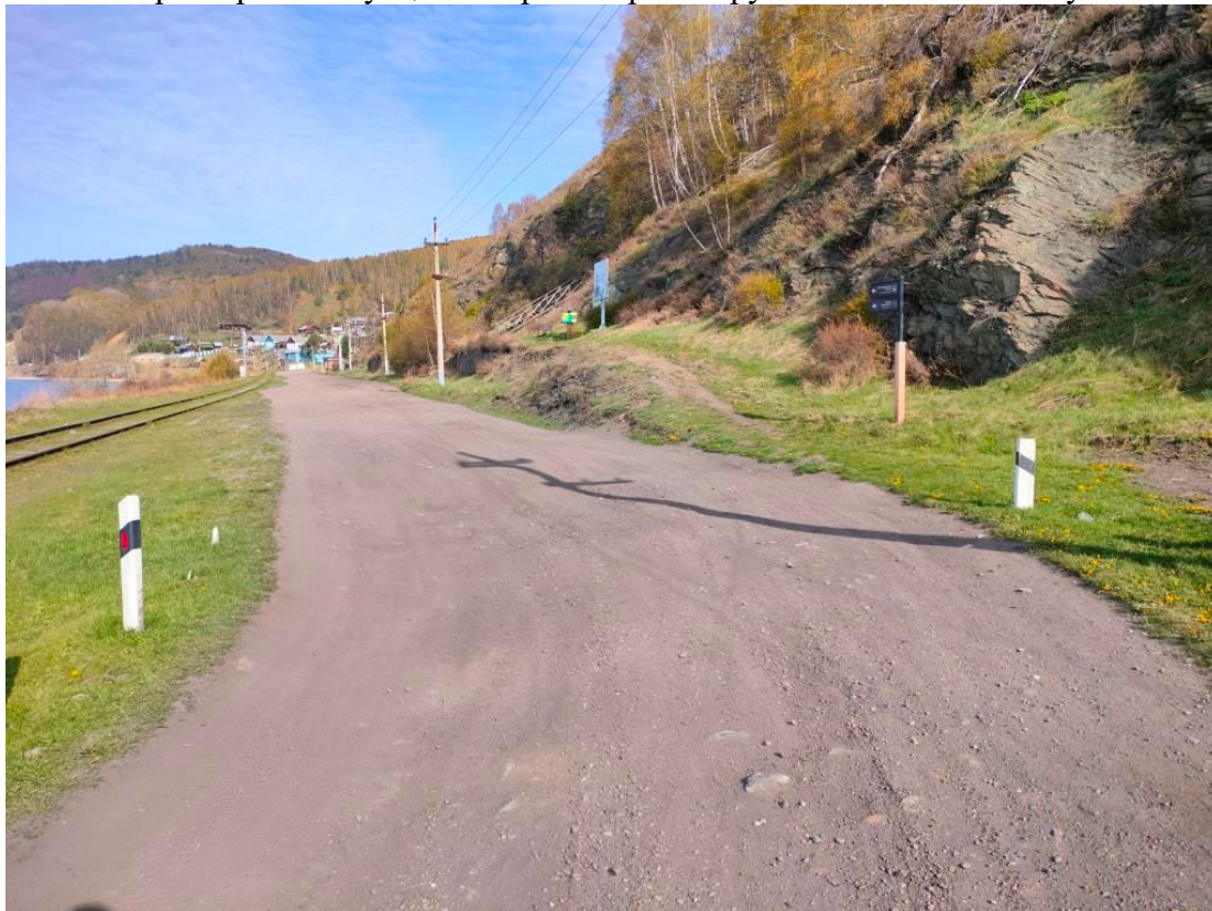
Рисунок Е.4 – Характерная ситуация по трассе проектируемой КВЛ 10 кВ на участке п. Байкал
