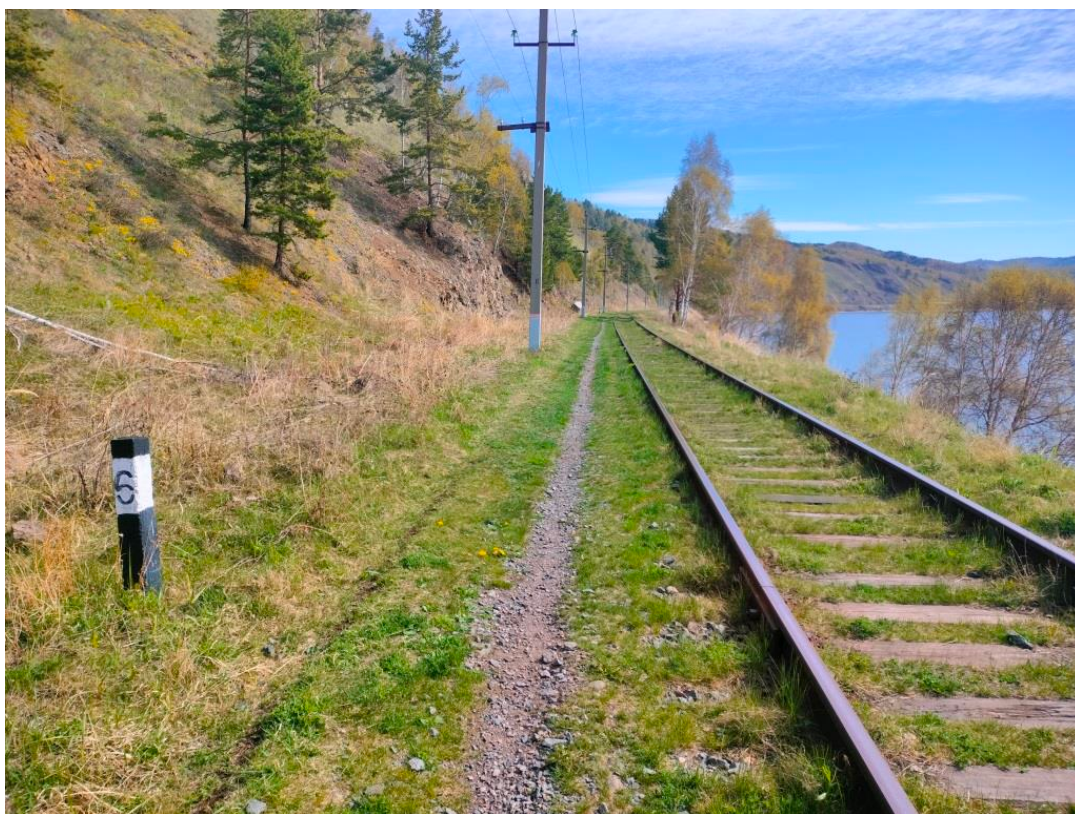
Рисунок Е.13 – Характерная ситуация по трассе проектируемой КВЛ 10 кВ на участке между р. Щелка и Зобушка
