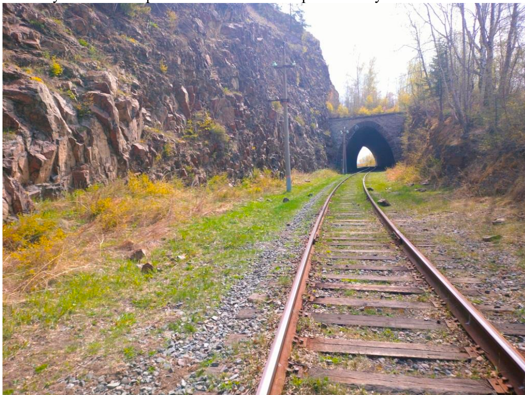
Рисунок Е.18 – Противооползневая галерея №1 на участке КВЛ 10 кВ
