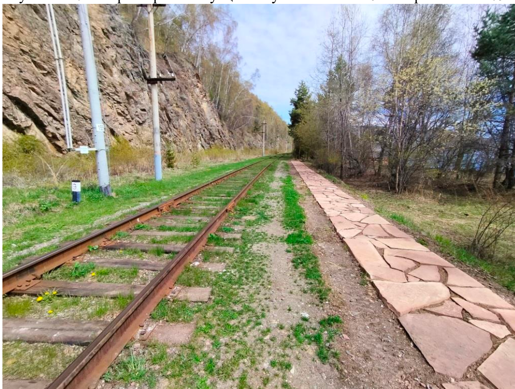
Рисунок Е.28 – Характерная ситуация на участке КВЛ 10 кВ в районе ОП 80 км
